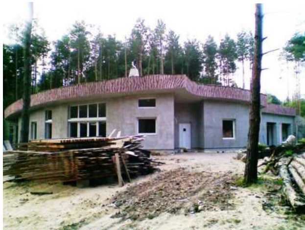
Fot.8 Dom - widok od frontu
