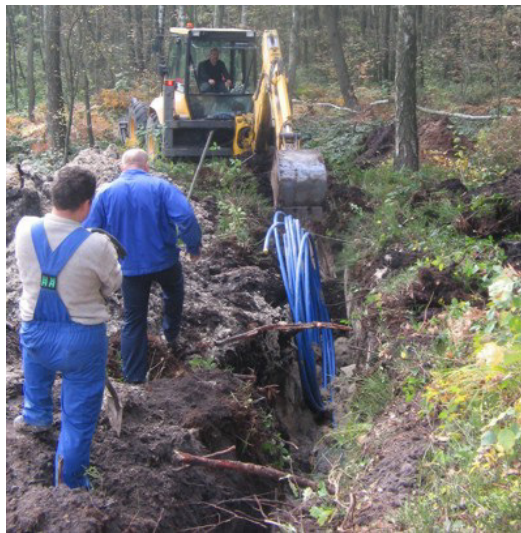
Fot. 4 Przygotowanie dolnego źródła - poziomy wymiennik gruntowy
