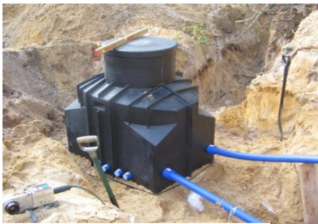
Fot. 5 Studnia kolektorowa dolnego źródła
