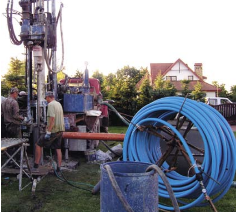
▲ Proces wiercenia otworów kolektora pionowego
