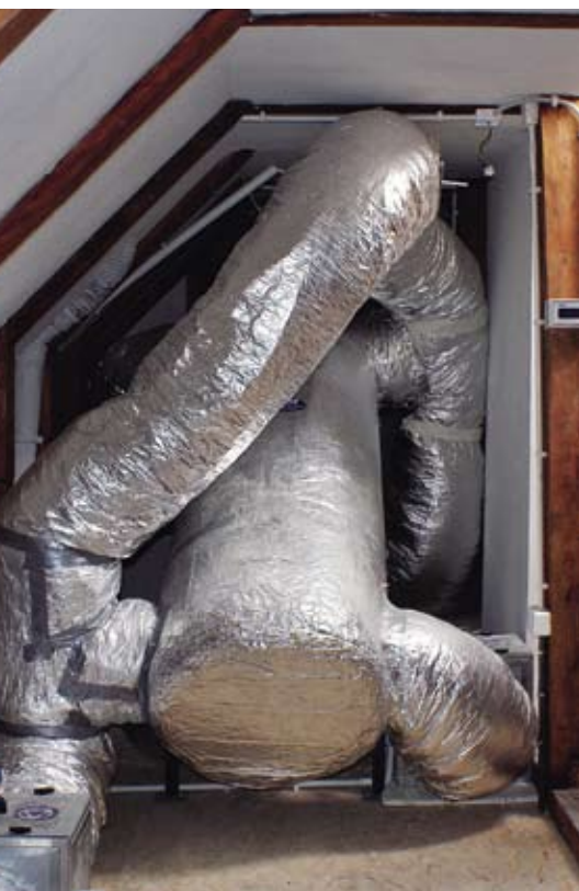
▼ Wentylacja na poddaszu nieużytkowym w domu w okolicach Hrubieszowa
