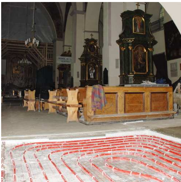
Fot.5 Wnętrze kościoła, pętla ogrzewania podłogowego przed wykonaniem wylewki jastrychowej.
