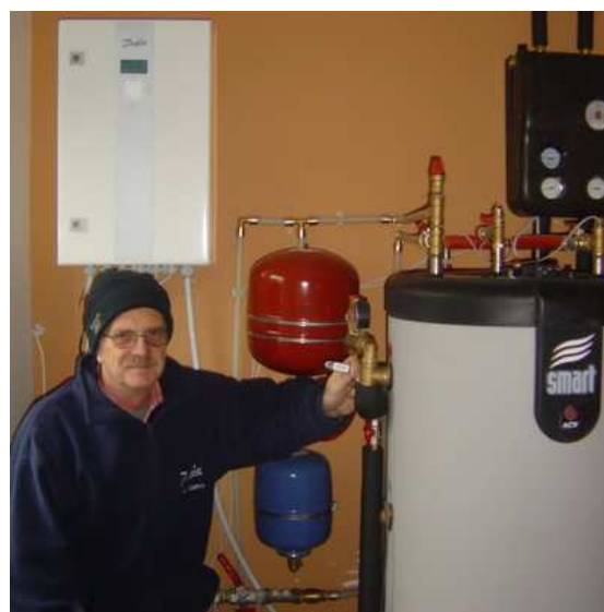
fot. 4, 5 Krzysztof Długosz przy powietrznej pompie ciepła Danfoss DHP-AX oraz przy węźle cieplnym (od lewej: panel sterujący pompą ciepła, zasobnik buforowy)
