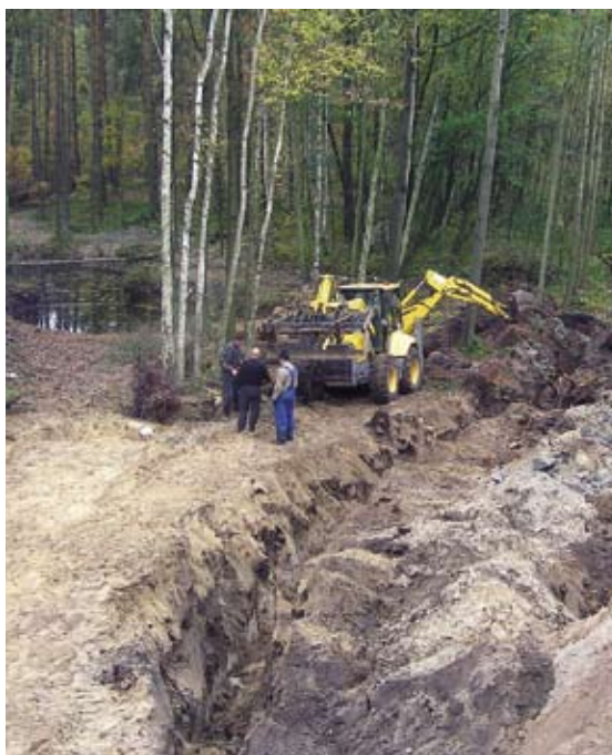
▲ Prace związane z zakopaniem kolektora płaskiego wymagały dużej sprawności od operatora koparki oraz całej ekipy
