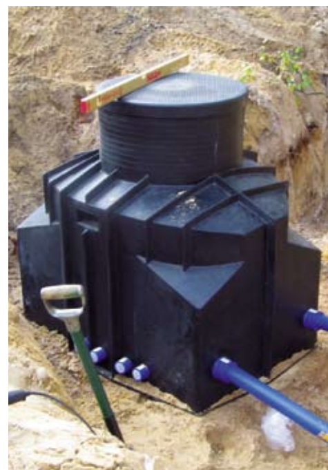
▲ Studzienka rozdzielcza, w której łączy się pętla kolektora poziomego (przed zakopaniem). Po prawej stronie widoczne są rury łączące to miejsce z pompą ciepła znajdującą się w budynku
